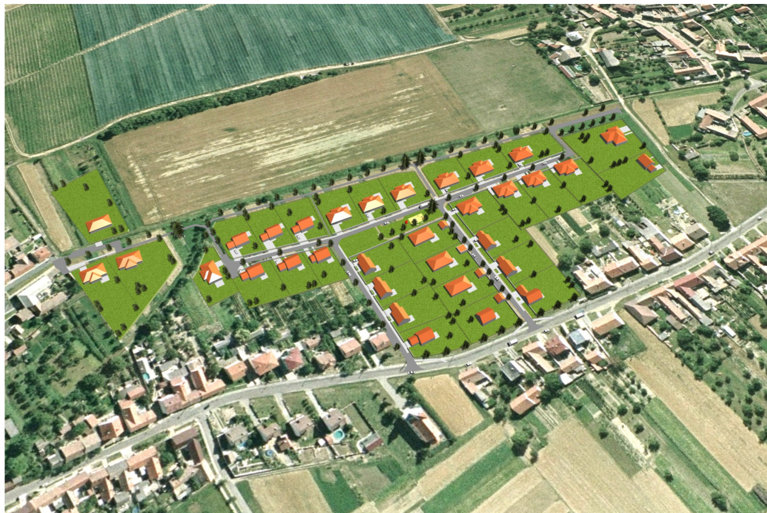
POHLED OD MAŠOVIC - OD SEVEROZÁPADU
